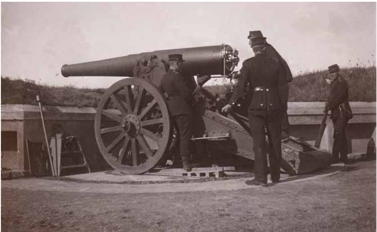
15 cm lang jernkanon på betonbrisken. Soldaten th. står klar med en spage, når kanonen skal rettes i siden. Han bakser svansen på kanonen med spagen. (Cranil)
