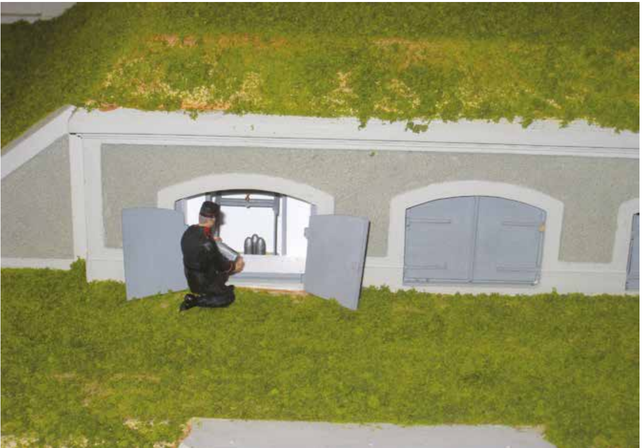
Nr. 6 er ved at hente en granat fra ophejsningsanordningen. Bag ståldørene til højre var der plads til forhåndsammunition, så skydningen hurtigt kunne gå i gang, når det var nødvendigt. (Model bygget af Niels Eriksen - Foto: Tom Wismann)
